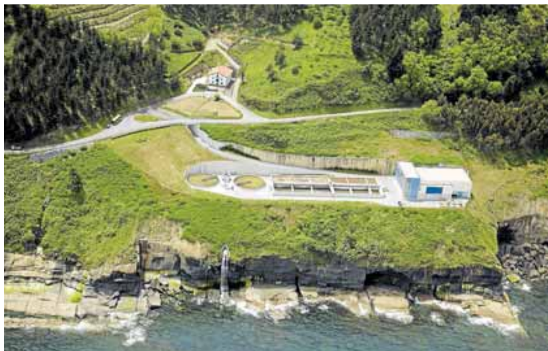
Estación Depuradora de Aguas Residuales de Ondarroa.
